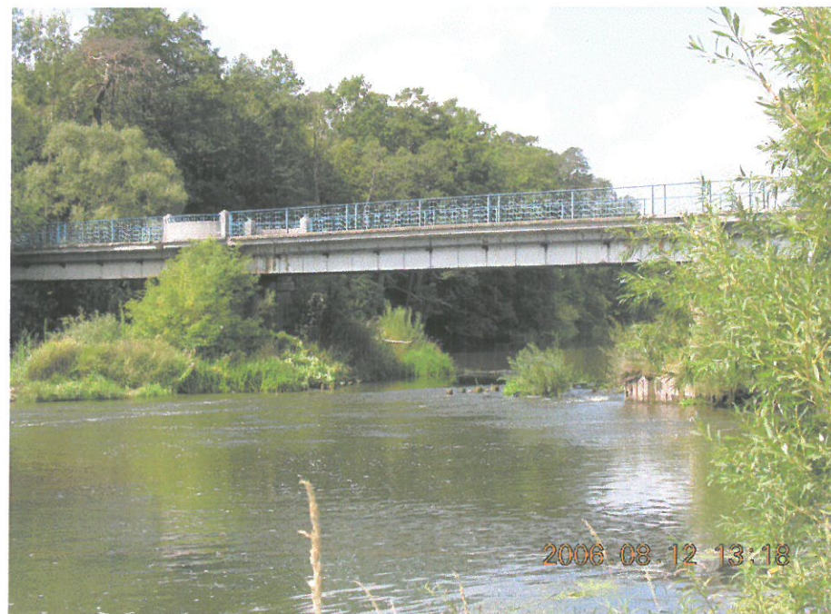
Widok mostu na rz. Pilicy od strony dolnej wody
