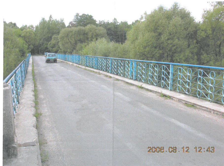
Widok mostu na rz. Pilicy - jezdnia
