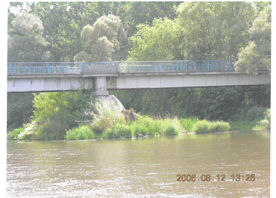
Widok mostu na rz. Pilicy od strony górnej wody
