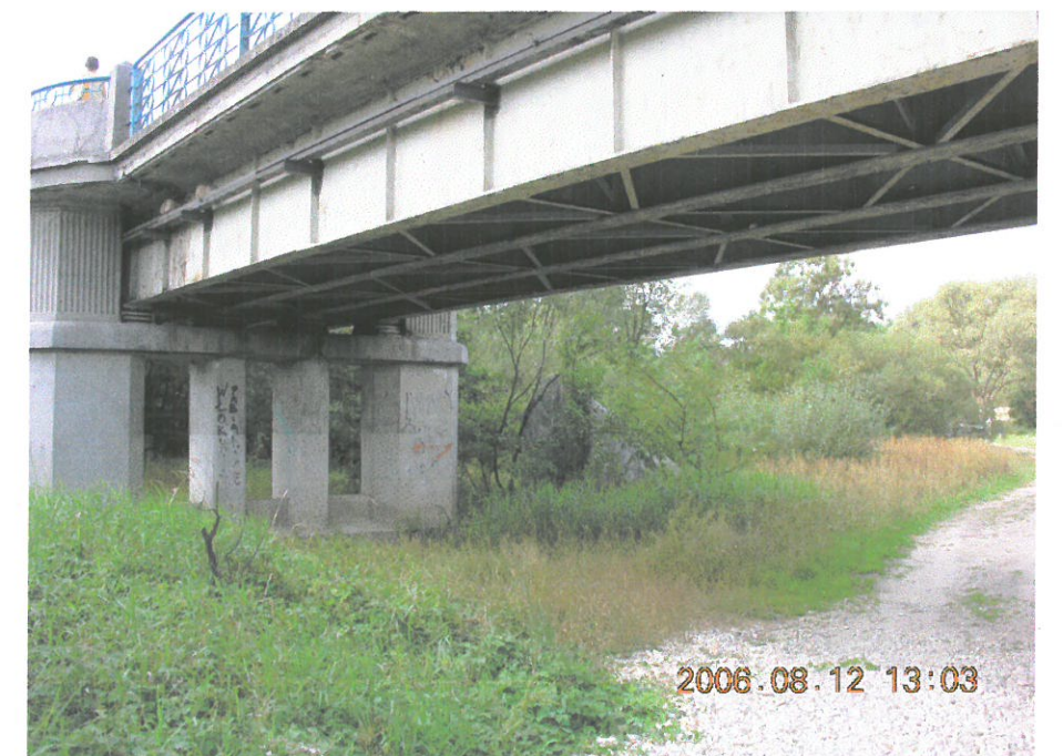
Widok mostu na rz. Pilicy - podpora i dźwigary nośne
