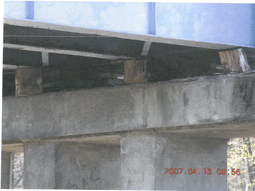
Fot. 37. Podparcia dźwigarów stalowych w strefie łożysk – podpora nr.3.
