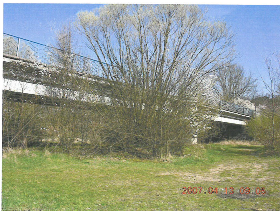
Fot. 42. Widok mostu od strony WD – otoczenie mostu.
