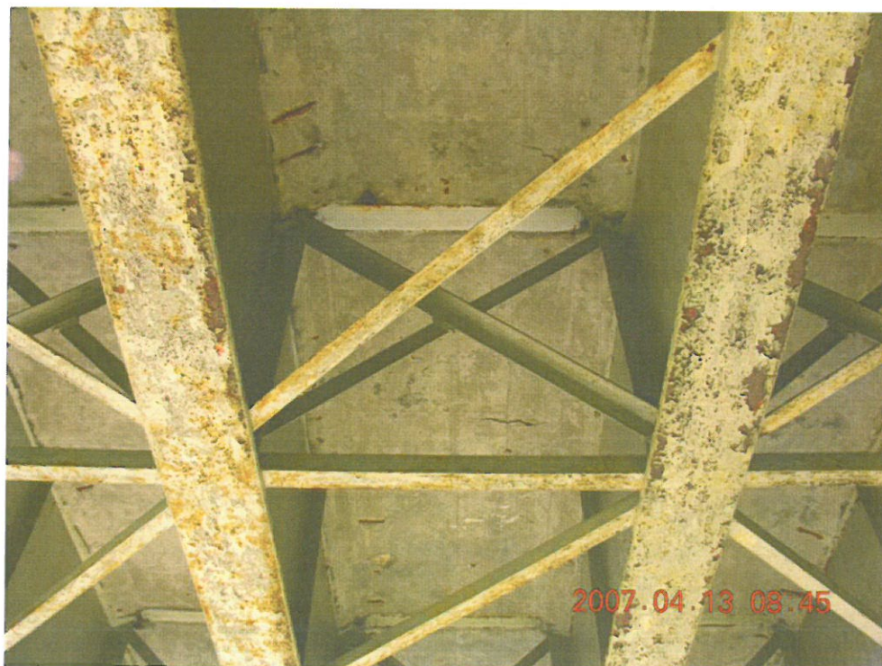
Fot. 30. Widok dźwigarów i płyty pomostu od spodu mostu przy 4 podporze.
