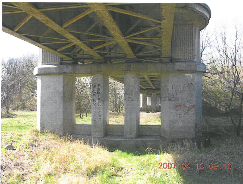
Fot. 20. Widok podpory ażurowej. Podpora nr. 1.
