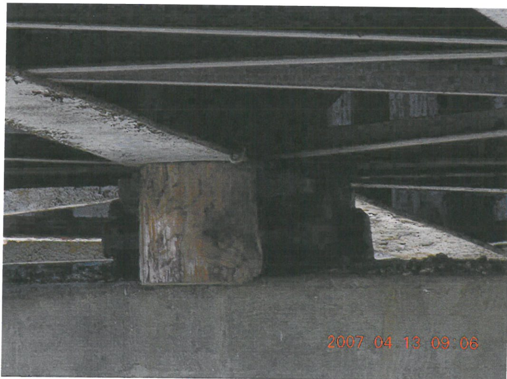
Fot. 38. Podparcie dźwigarów w strefie łożysk- podpora nr.4.
