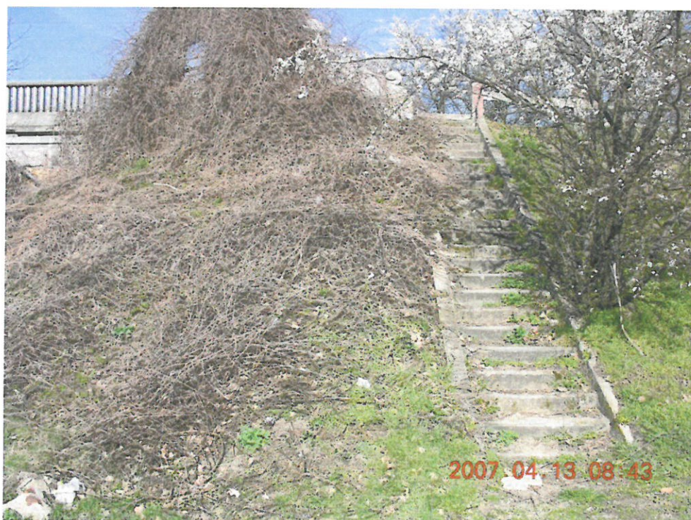
Fot. 40. Schody skarpowe od strony WD / dojazd do mostu od strony Spały/.
