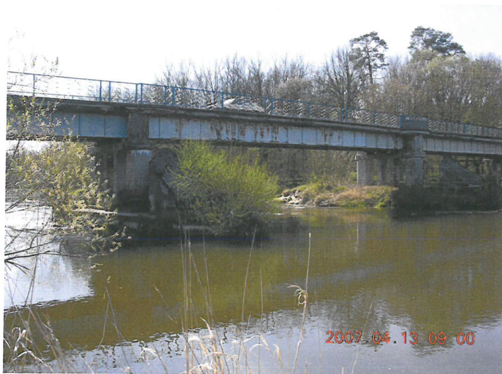
Fot. 1. Widok mostu od strony WG .
