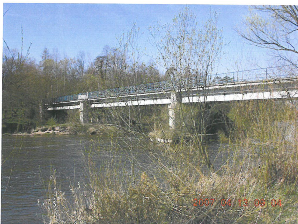
Fot. 2 Widok mostu od strony WD.
