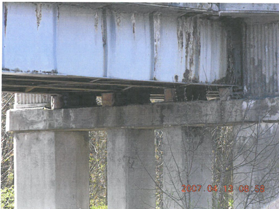
Fot. 36. Podparcia drewnianymi balami dźwigarów w strefie łożysk- podpora nr. 4.
