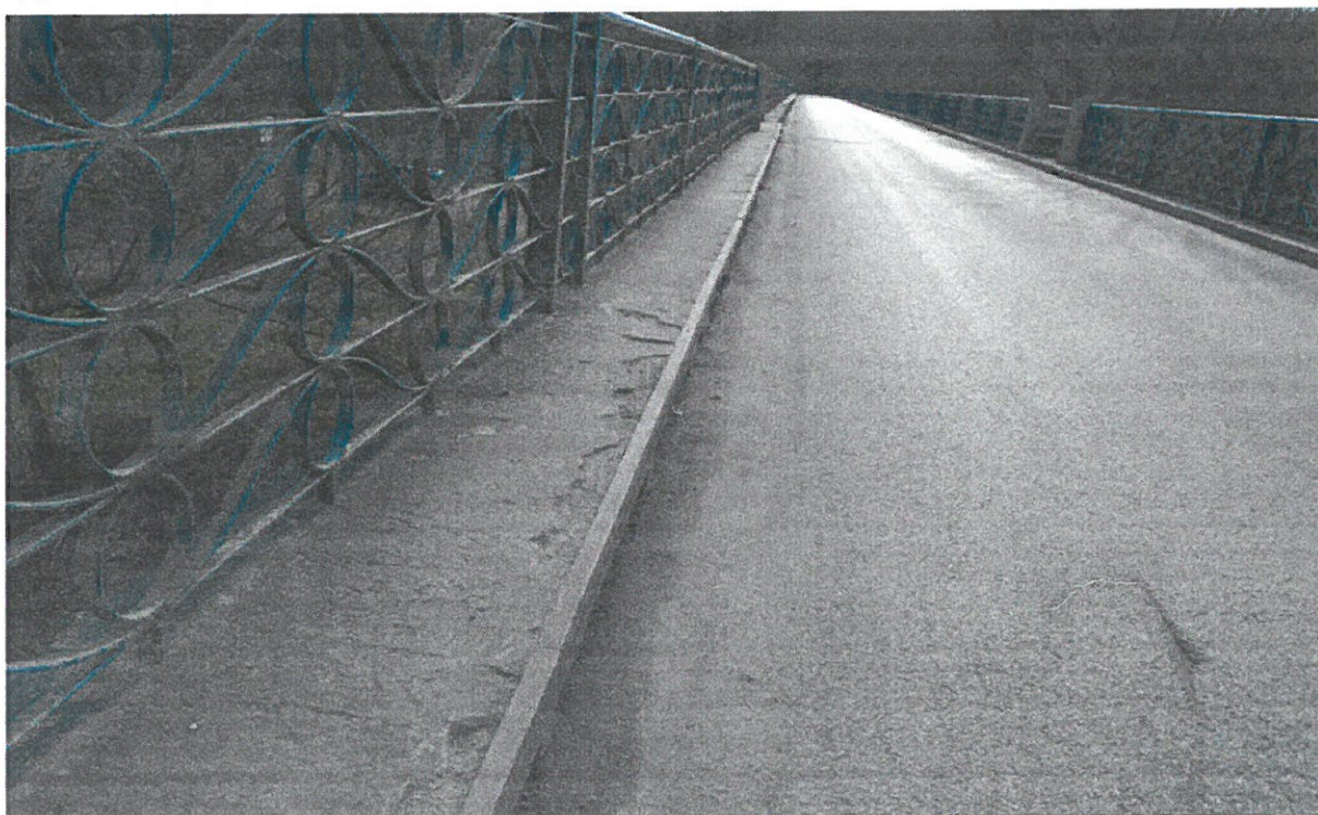
Uszkodzenia nawierzchni betonowej (uszkodzenia powierzchniowe)
