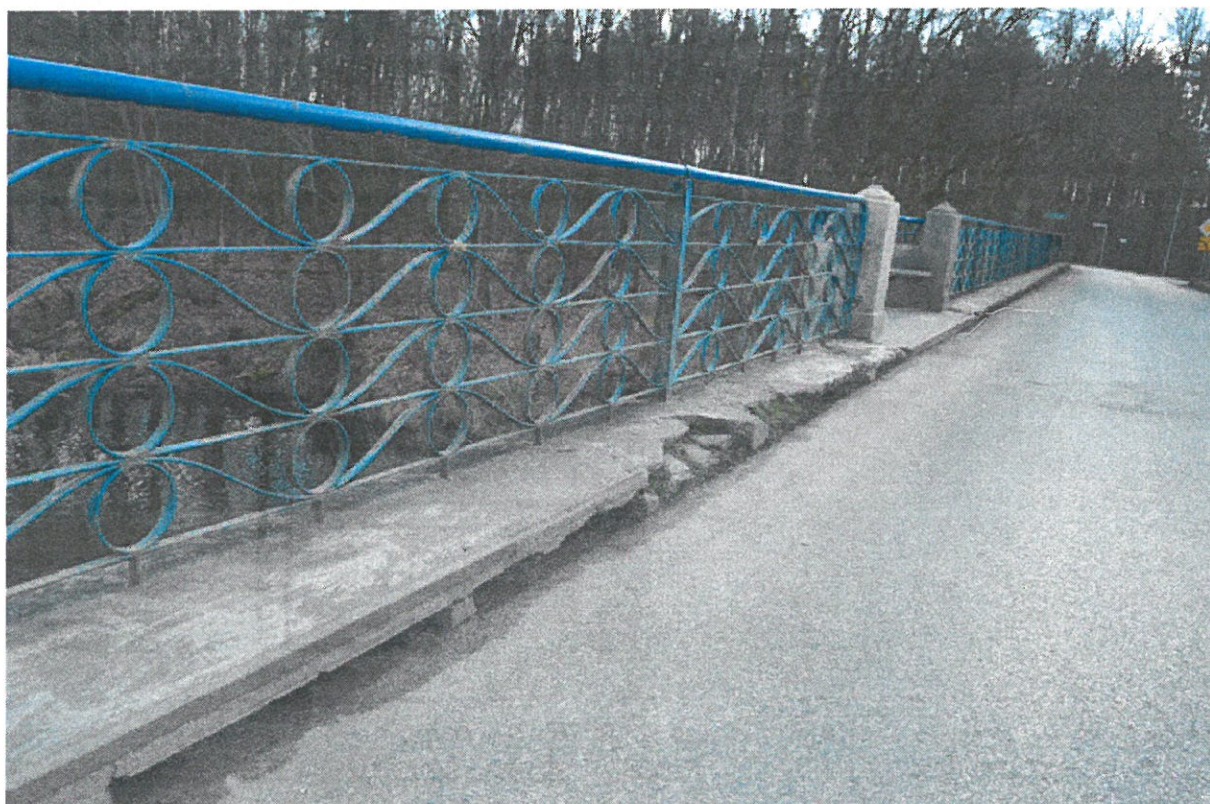
Zniszczenie konstrukcji opaski bezpieczeństwa.,
