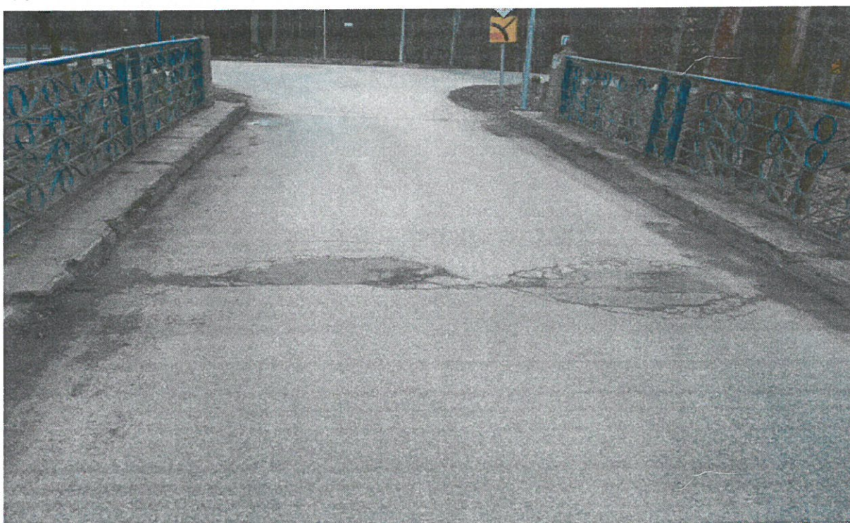
Uszkodzenie nawierzchni nad dylatacją końcową nad lewobrzeżnym przyczółkiem.
