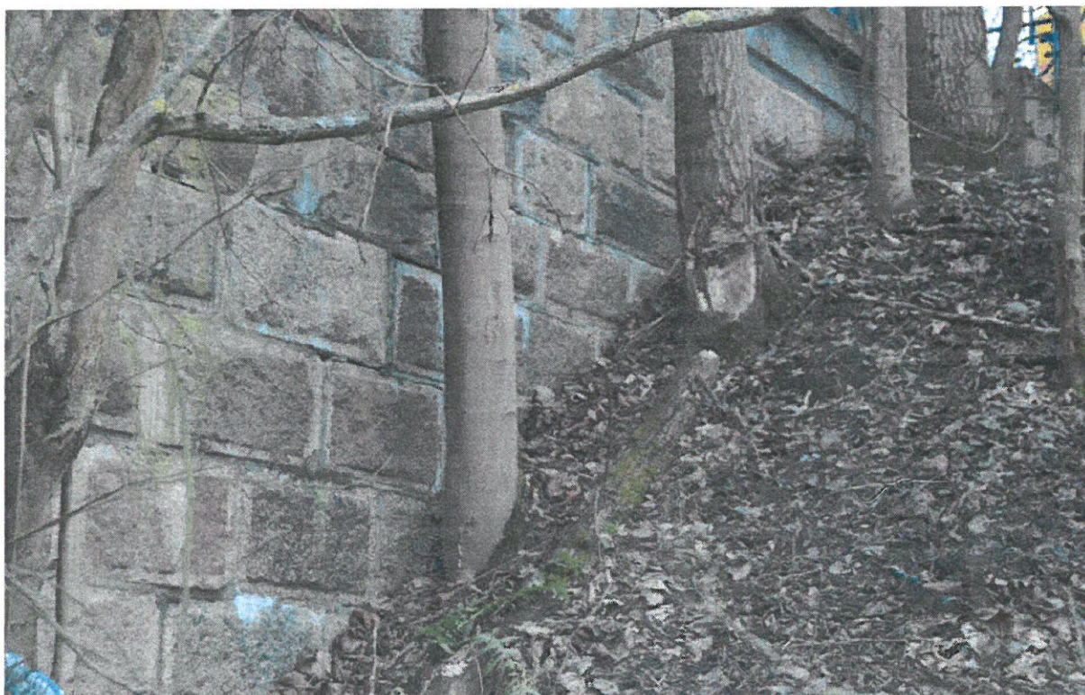
Prawy brzeg – dolna woda. Obficie porastające drzewa tuż przy przyczółku mogą powodować jego degradację.
