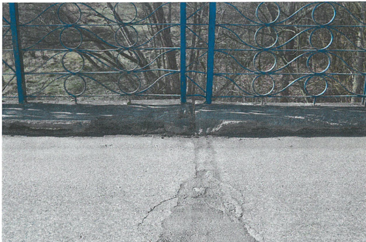
Uszkodzenie opaski nad dylatacją
