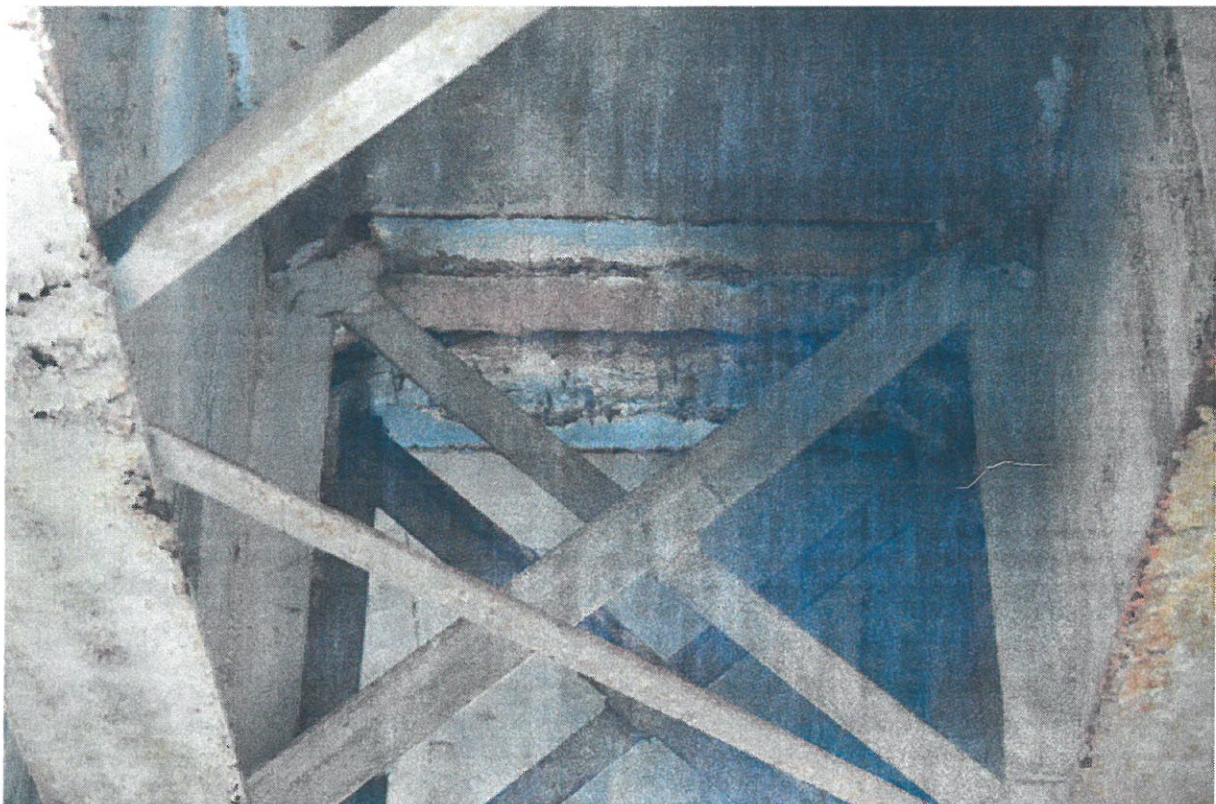
Uszkodzenia krawędzi płyty pomostu w obrębie nieszczelnych urządzeń dylatacyjnych.
