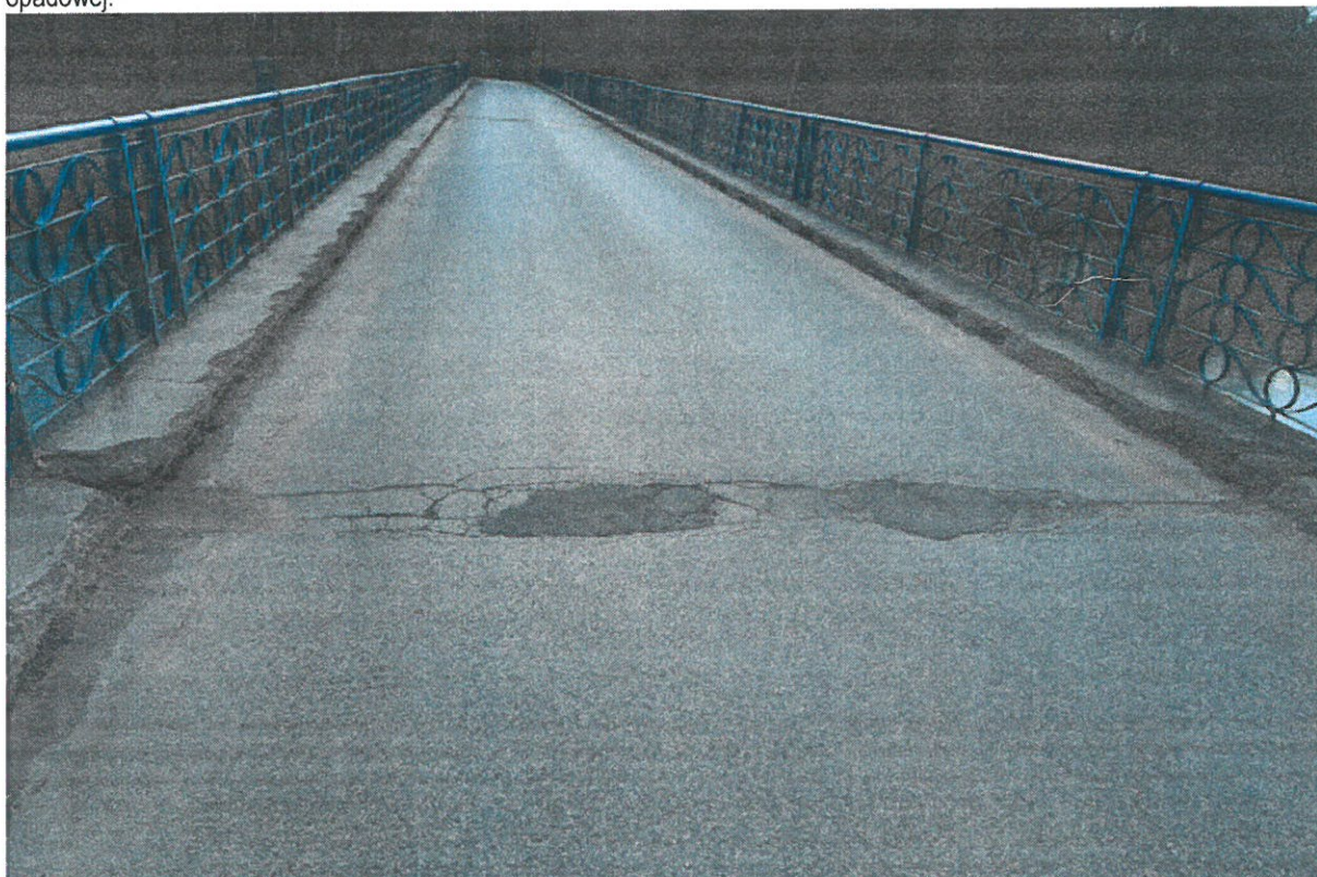
Pęknięcie nawierzchni nad kolejną dylatacją.
