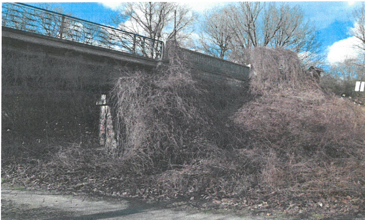
Lewy brzeg – dolna woda – skarpa nieuporządkowana, zarośnięta roślinnością.
