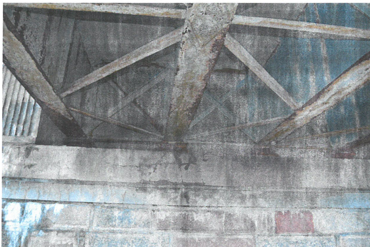
Masywne łożyska stalowe wymagają oczyszczenia i konserwacji oraz ochrony przed zawilgoceniem.
