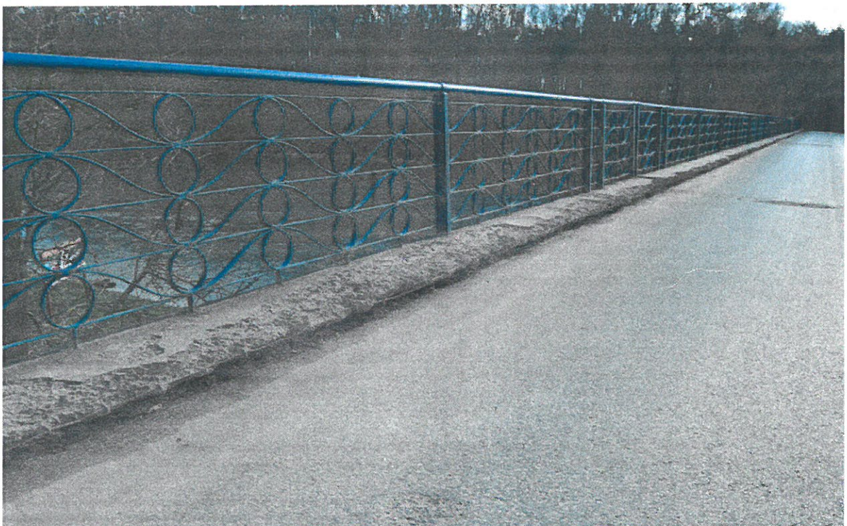
Degradacja betonu opaski chodnikowej.
