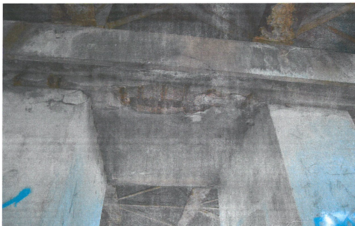
Zbliżenie widoku uszkodzeń betonu oczepu filara.
