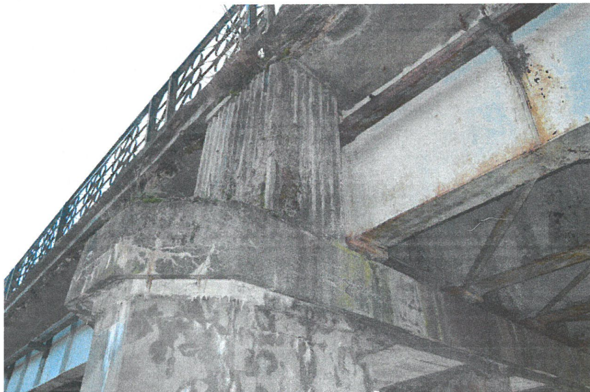
Korozja i uszkodzenie betonowego filara ozdobnego nad filarem pośrednim.
