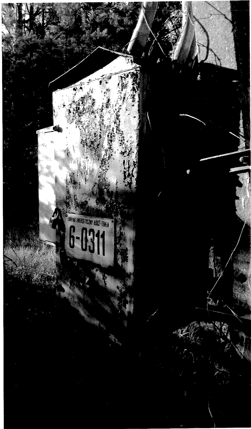
Przykład napowietrznej stacji transformatorowej ( lok. ul. Sosnowa Inowłódz)
