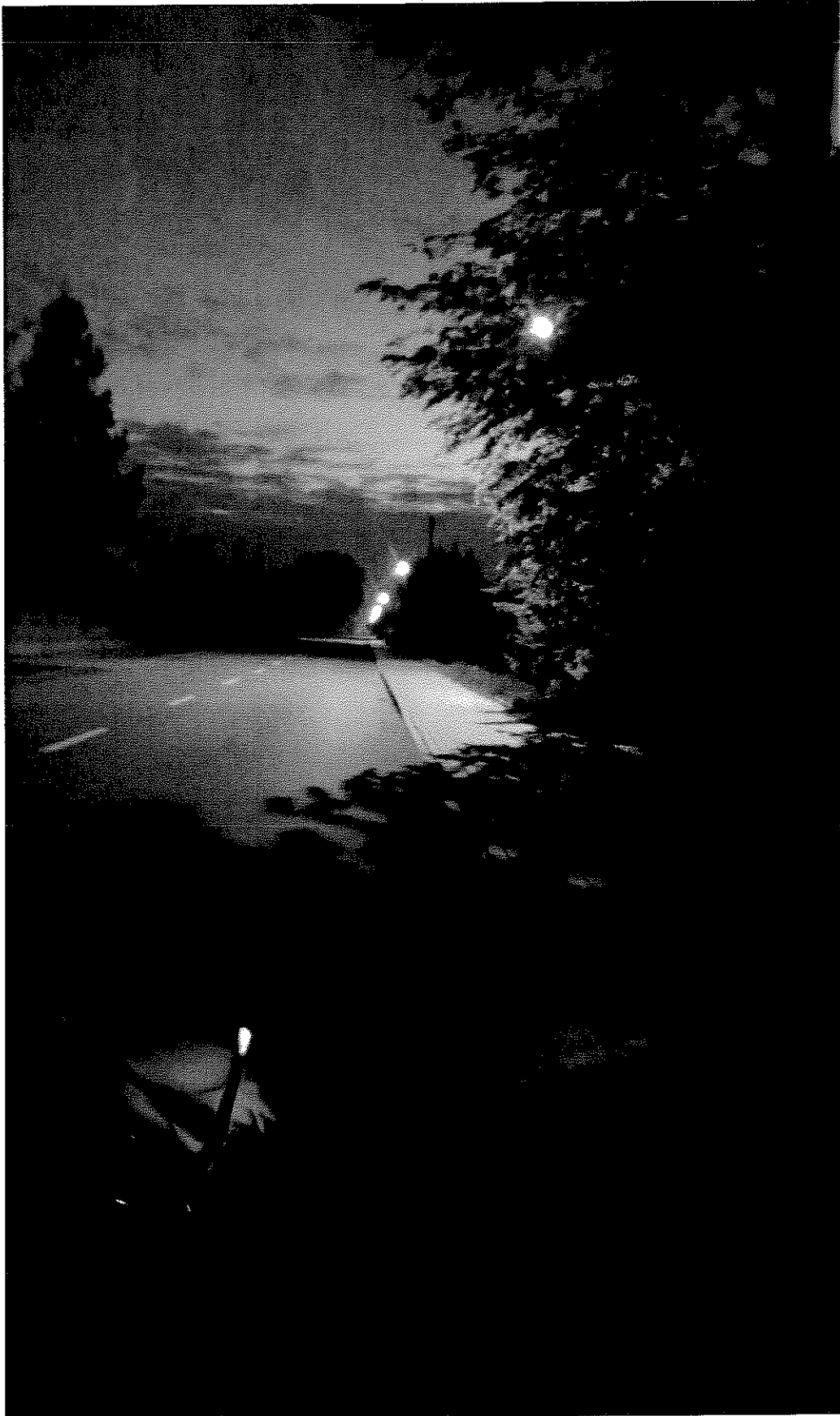
Przykład niedoświetlenia drogi pomiędzy kolejnymi oprawami. (lok. Królowa Wola )
