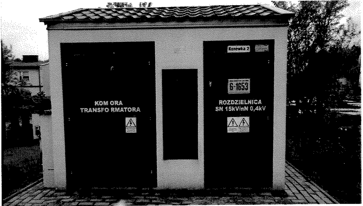
Przykład stacji transformatorowej ( lok. Konewka)
