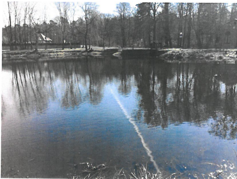
Fot. 1 Widok od strony zbiornika na groblę czołową zbiornika z jazem, służą i mniczem.
