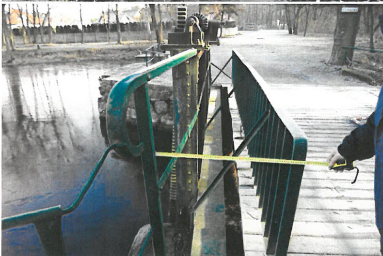
Fot. 5 Pokład mostu na jazu, kładka robocza, urządzenie podnoszące.
