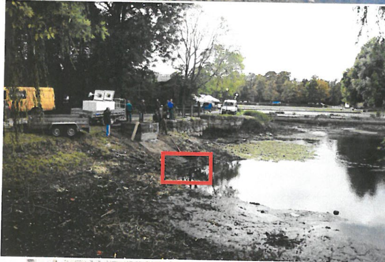
Fot. 11 Widok od strony wschodniej na śluzę, jaz oraz basen (w głębi). Oznaczona górna część kraty na wlocie śluzu.
