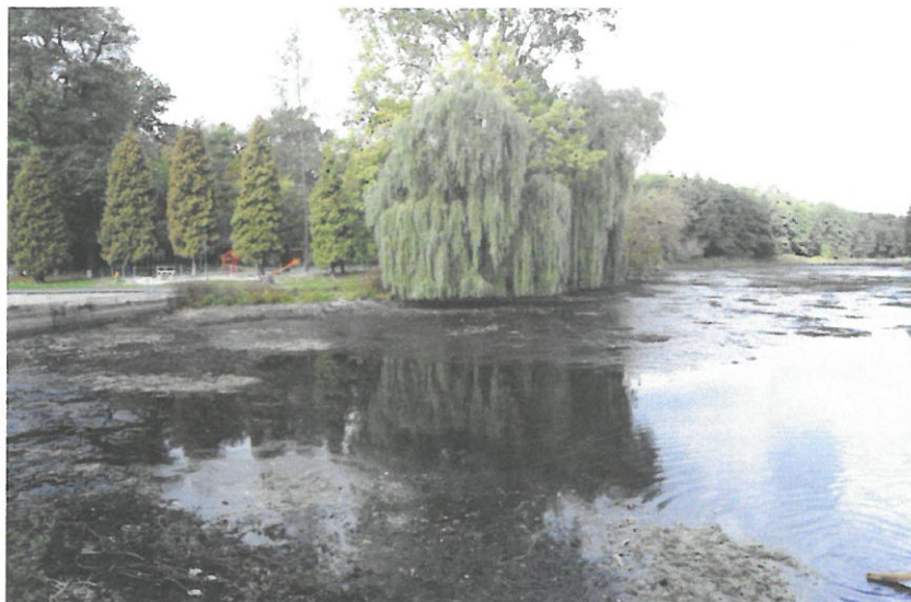
Fot.1 Widok zbiornika od strony grobli czołowej. Widoczne znaczne zamulenie dna.
