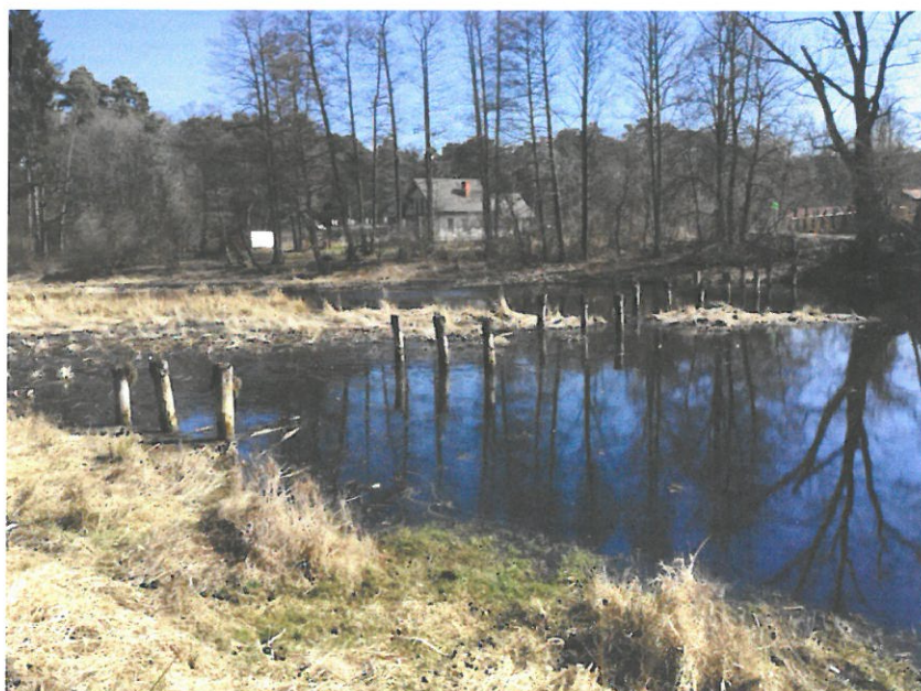
Fot.2 Widok zbiornika od strony zachodniej. Pozostałości dawnej kładki w miejscu projektowanej grobli północnej. Widoczne znaczne zamulenie dna.
