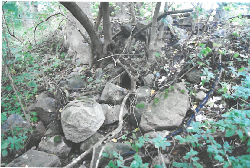
Fot.5 Wylot rurociągu doprowadzającego wodę do stawu parkowego.
