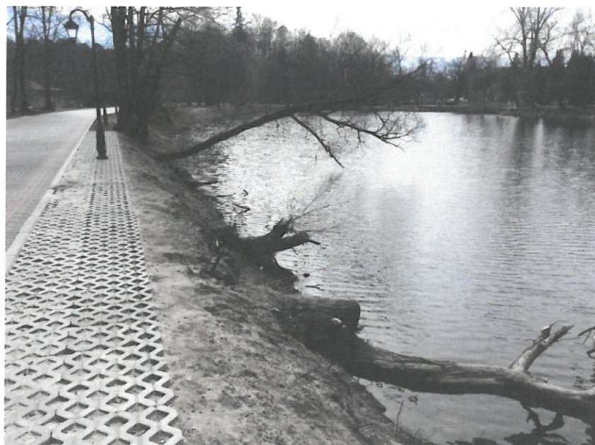
Fot.3 Widok zbiornika od strony wschodniej. Widoczna nowa nawierzchnia z kostki brukowej.
