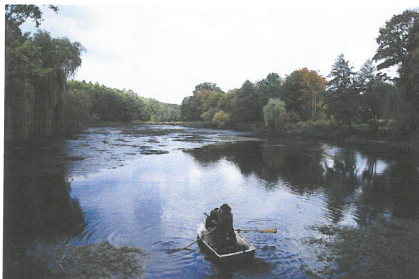
Fot. 2 Widok na zbiornik z jazu. Widoczne znaczne zamulenie dna zbiornika.
