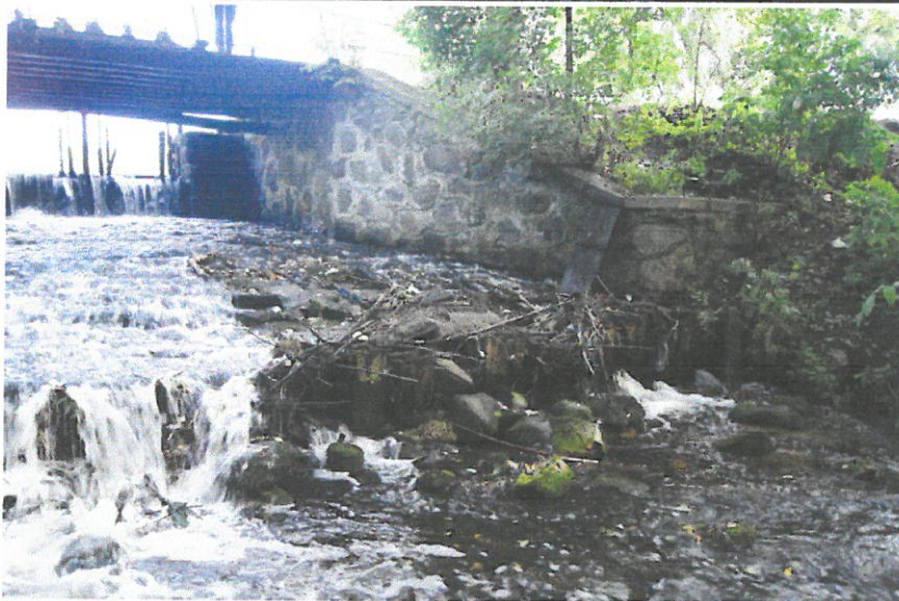
Fot. 8 Zniszczony wylot płyty dennej, zniszczona drewniana ścianka szczelna, brak umocnień dna rzeki poniżej wylotu.
