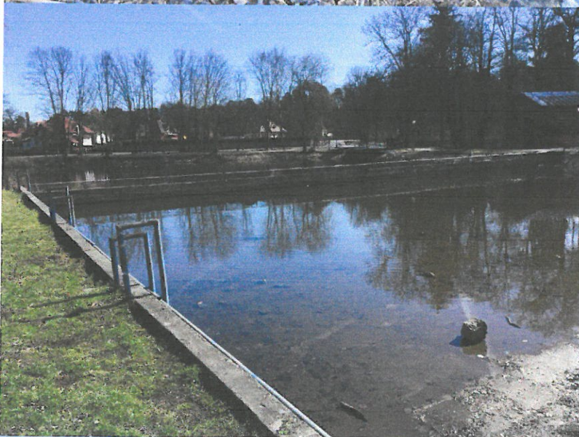
Fot. 14 Ściana północna basenu z elementami metalowymi do usunięcia. W głębi – oporowa ściana wschodnia. Ściany do pozostawienia.
