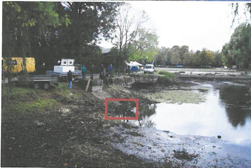
Fot. 11 Widok od strony wschodniej na śluzę, jaz oraz basen (w głębi). Oznaczona górna część kraty na wlocie śluzy.
