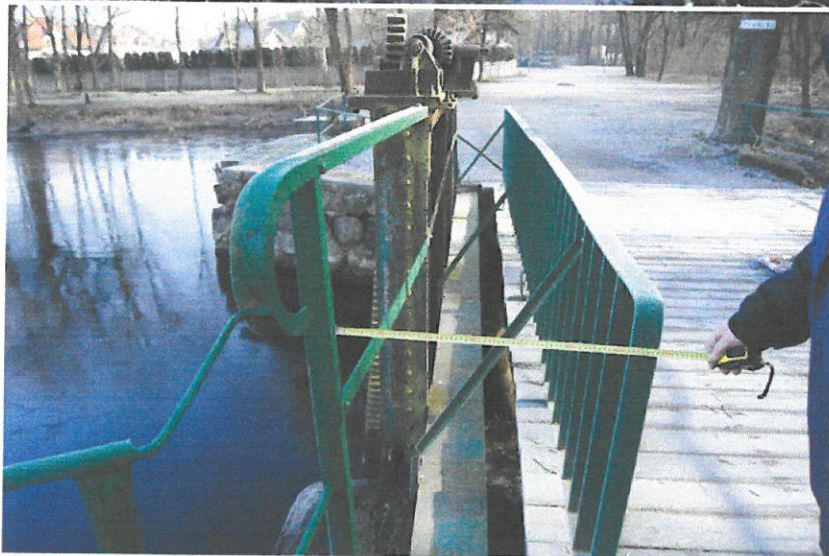
Fot. 5 Pokład mostu na jazie, kładka robocza, urządzenie podnoszące.
