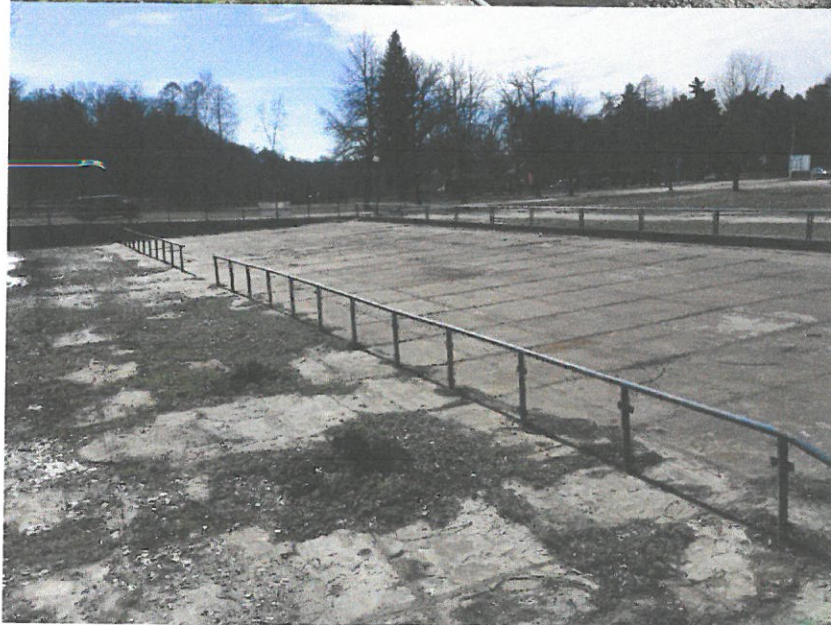
Fot. 15 Umocnienie dna basenu płytami betonowymi. Widoczne barierki do demontażu.
